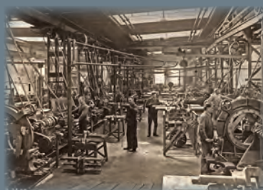
Die Motorenfertigung bei Deutz in Oberursel
