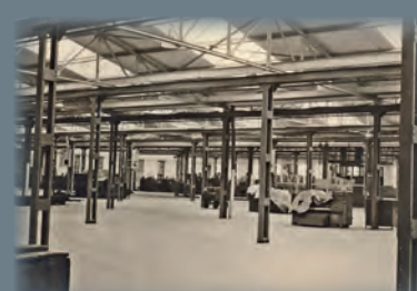
Die Hallen mussten komplett saniert werden
