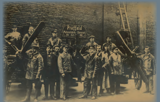
Das Prüffeld der Umlaufmotoren
