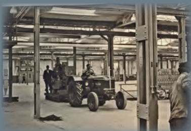
Die ersten Maschinen werden aufgestellt
